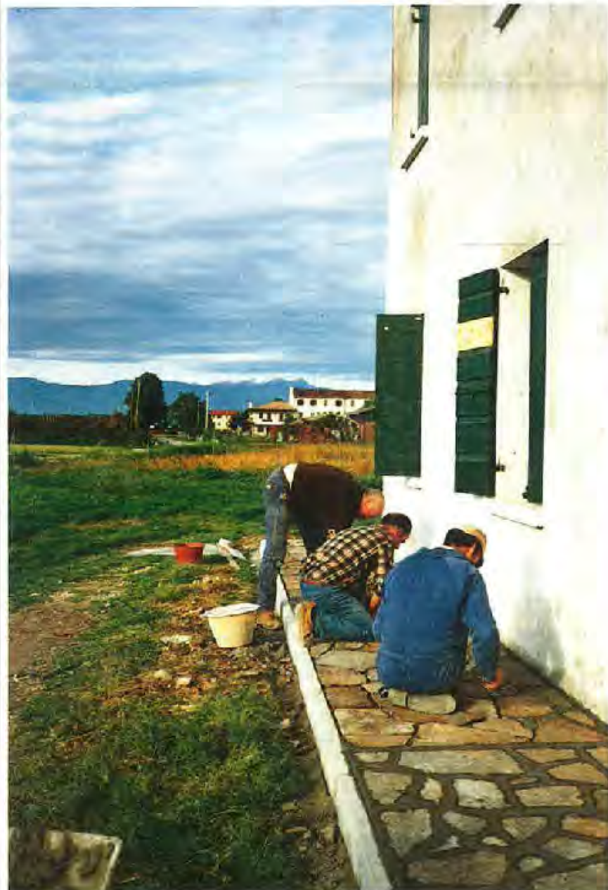
Una squadra di volontari intenti alla posa della pavimentazione in porfido del marciapiede attorno alla Casa di Fontanelle.
